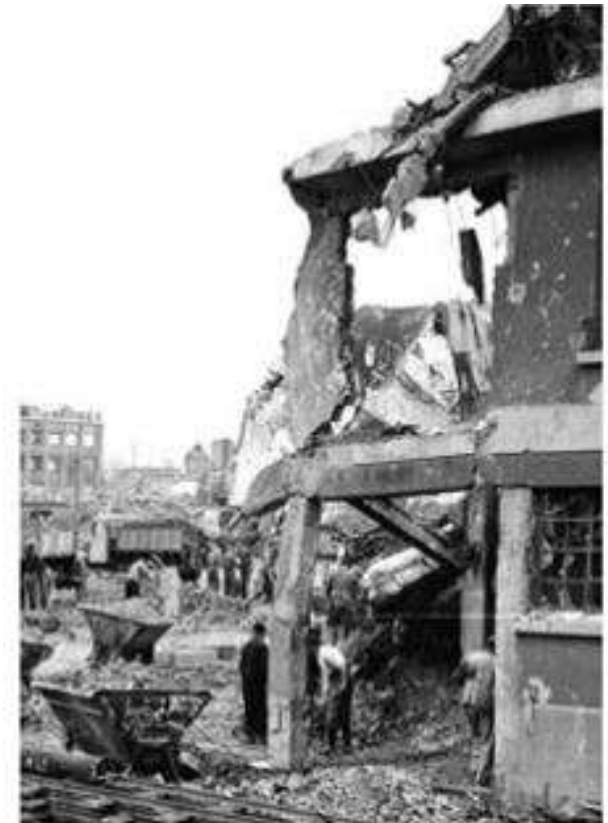
Déblaiement dans les ruines de Caen, 1945. © ECPAD/Vincent Verdu
