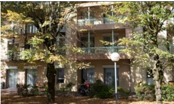
Bâtiment D façade
