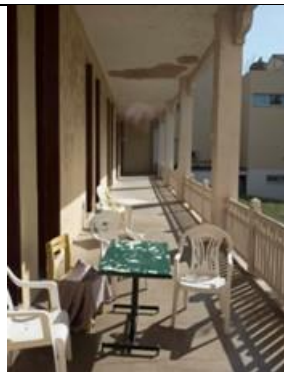
Coursive bâtiment A
