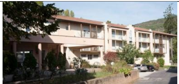
Bâtiment D – vue générale
