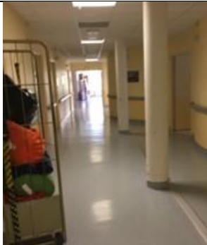
Circulation bâtiment B
